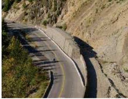
Steinschlag- und Erdbeben-Dämme
